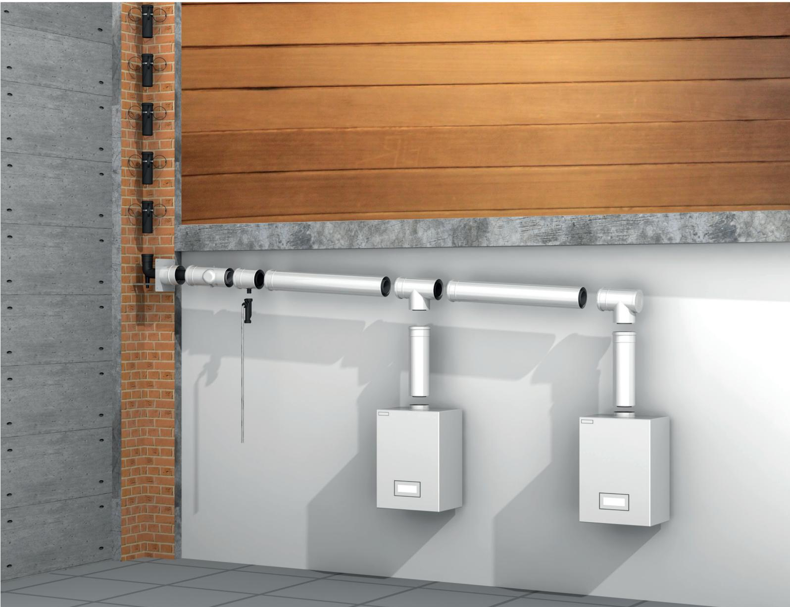
Von Kaskaden ist die Rede, wenn mehrere Feuerstätten in einem Heizraum miteinander verbunden sind und die Abgase aller Anschlüsse mit einem Abgassystem ins Freie geführt werden.
